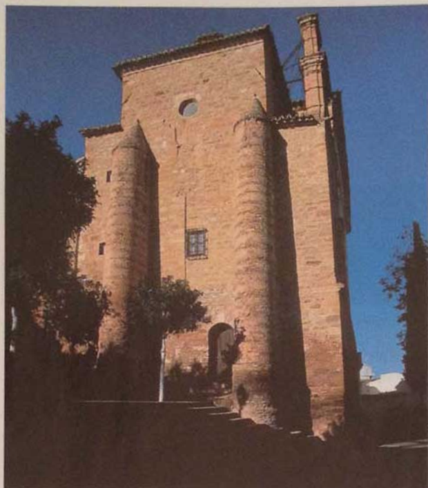
Contrafuertes en el santuario de los Santos, en Arjona
