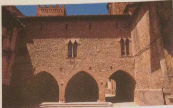
Casa de los templarios en La Iglesuela del Cid
