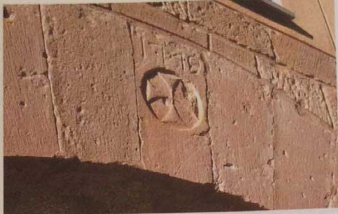
Cruz en el dintel de la casa del Temple, en Torres de Segre
