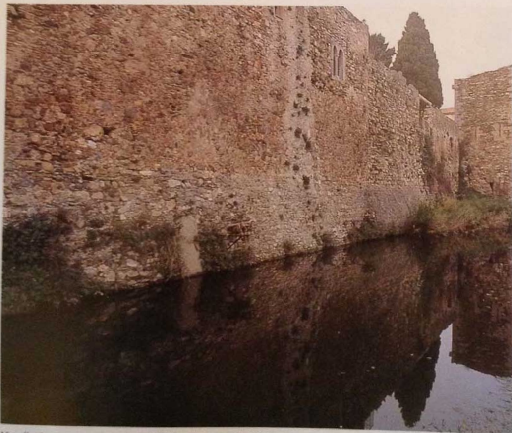
Muralla de Castelló d'Empúries, que fue encomienda del Temple
